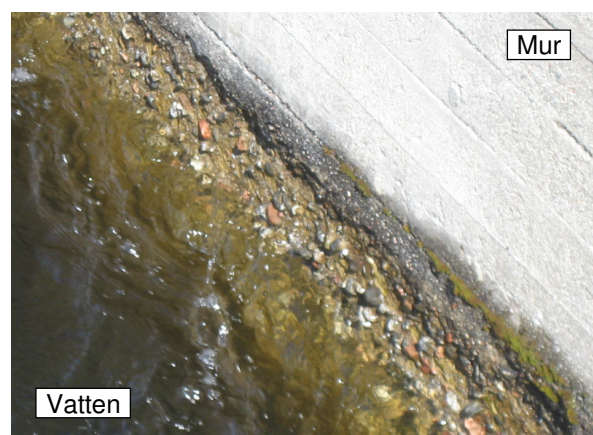
Figur 1. Frilagd ballast till följd av successiv avskalning av betongens yta i vattenlinjen.
