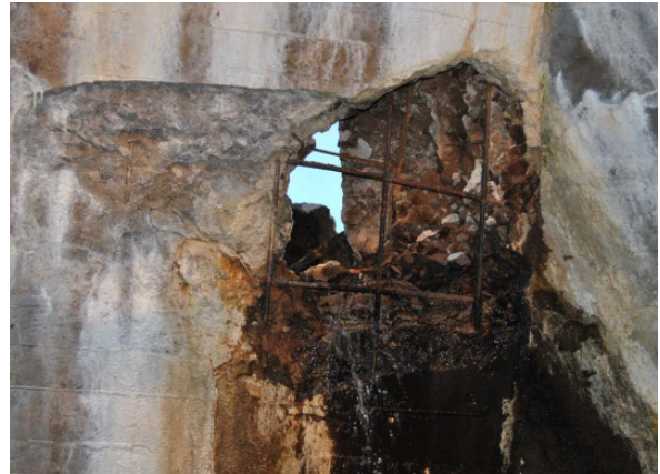
Figur 6. Ett genomgående hål (0,8 m i bredd och 1,2 m i höjd) i en allvarligt skadad betongdamm.
